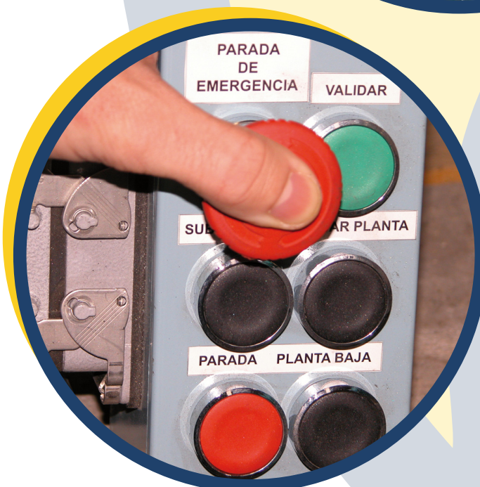
Dispositivo de parada de emergencia en un montacargas.
