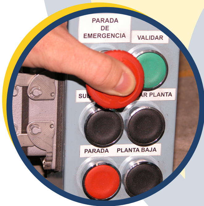
Dispositif d'arrêt d'urgence sur un monte-charge.
